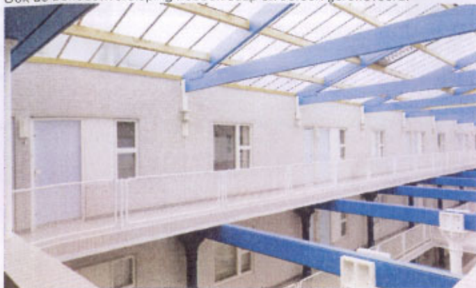
Een deel van het dak van het pakhuys is in 1989 vervangen door glas.
